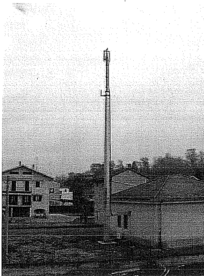
Foto 1: Traliccio strada Provinciale
